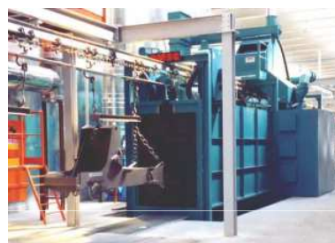
Tunnel in linea con verniciatura
